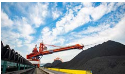
黄骅港智能化作业现场
